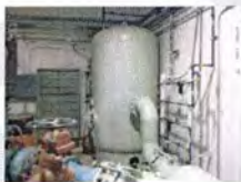
17. Effluent Surge Tank
